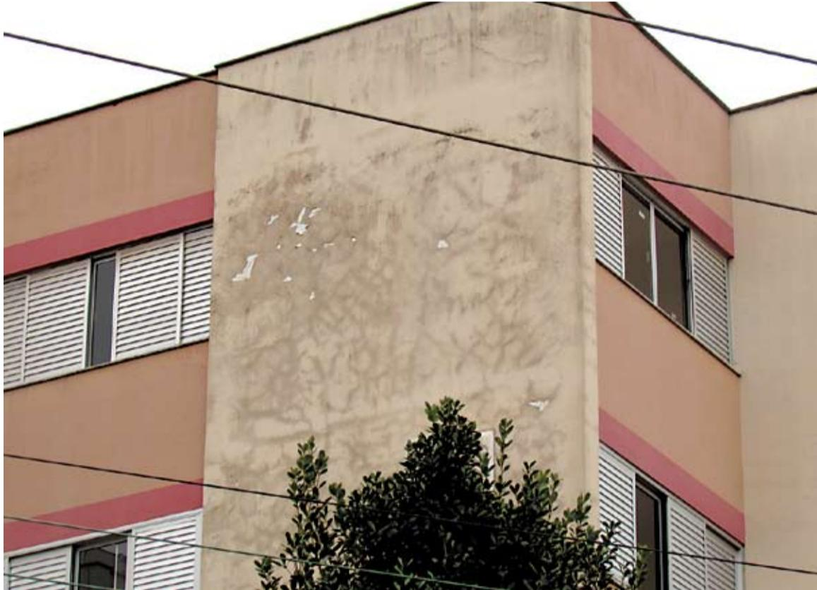
Entre as principais patologias causadas pela umidade estão as manchas, formação de bolor e o aparecimento de fissuras e trincas
